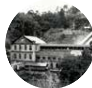
操業時の曽木発電所
