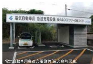
電気自動車用急速充電設備(屋久島町栗生)
