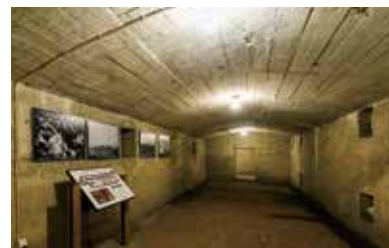
串良基地跡地下壕電信室跡〈鹿屋市〉
