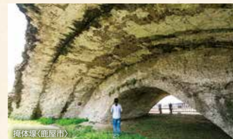
掩体壕(鹿屋市)
